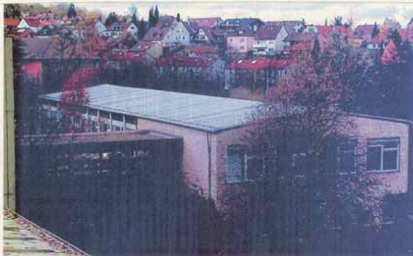
Südliche Hälfte des Nordbaudaches ( 8,20\text{m} \times 46,10\text{m} = 378,02 \text{ m}^2 ) DN 9^\circ ; Ausrichtung 0^\circ Süd
